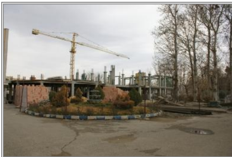
نمایی از ساختمان در حال احداث پژوهشگاه
